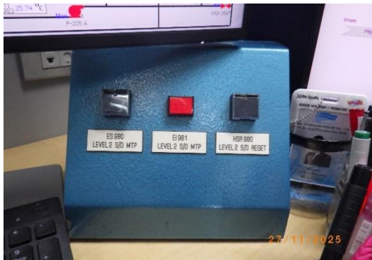
ระบบหยุดปั๊มอัตโนมัติ สถานีสูบน้ำส่งน้ำมันมาบตาพุด
