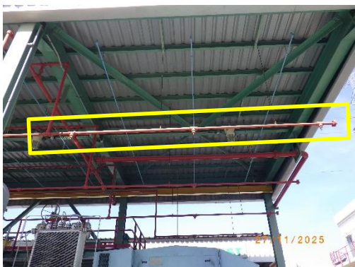
ระบบตรวจจับเปลวไฟ สถานีสูบน้ำส่งน้ำมันมาบตาพุด
