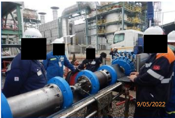
รูปที่ 2-14 การส่ง Intelligent Pig
