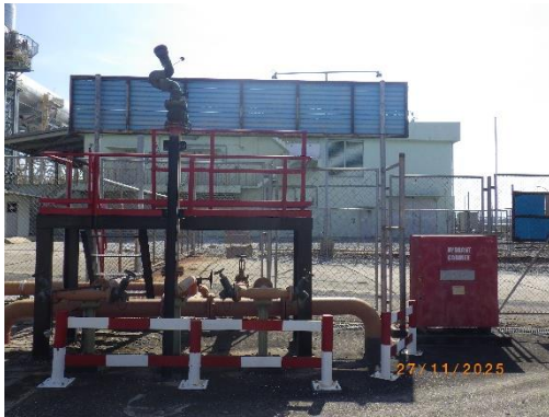
ระบบดับเพลิงอัตโนมัติ สถานีสูบน้ำ้ำมันมาบตาพุด
