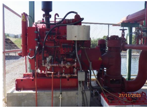
Fire Pump สถานีควบคุมระบบท่อที่ 652
